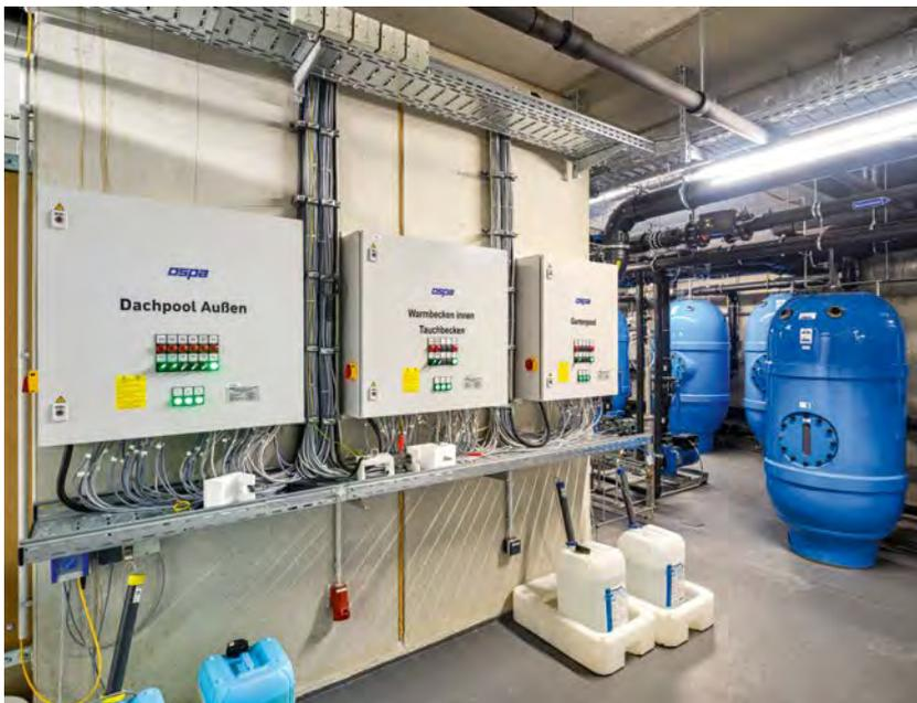
**Die Ospa-Schwimmbadtechnik im Untergeschoss der Anlage. Mehrere Umwälzkreisläufe versorgen die Pools mit frisch aufbereitetem Wasser.**
