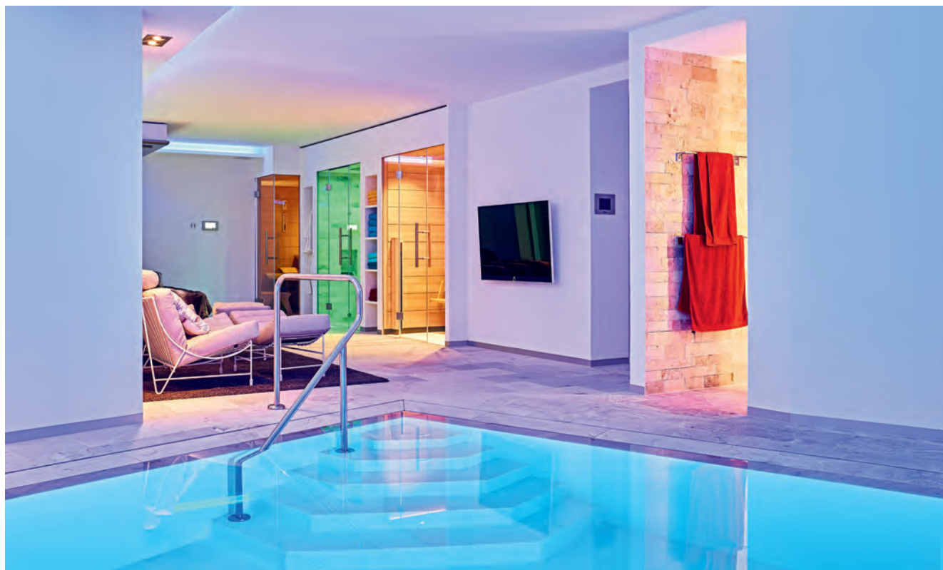
Einen bequemen Einstieg ins Schwimmbecken ist durch die fünfstufige Treppenanlage gewährleistet.
