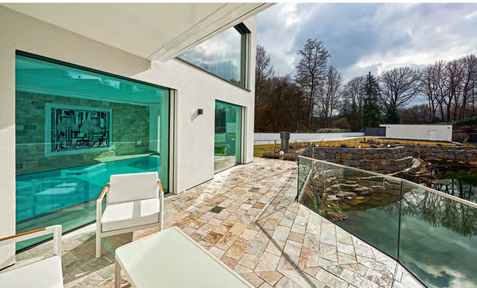
Oben: Ein kleiner Wellnessbereich mit Sauna, Dampfbad und Infrarotkabine wurde ebenfalls in die Schwimmhalle integriert. Unten: Feinsteinzeug kam nicht nur überall in der Schwimmhalle, sondern auch auf der Terrasse zum Einsatz.
