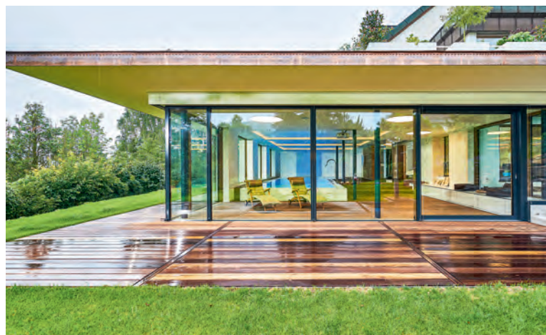
Aufgrund der starken Hanglage ist die Schwimmhalle auf zwei Ebenen angelegt mit Gefälle in der Längsrichtung des Beckens.
