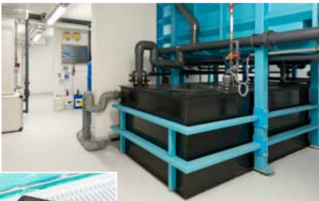
Unter dem VPS-Becken konnte platzsparend der Schwallwasserbehälter eingebaut werden. Über ein Tablet hat der Bauherr den Zugriff auf die Poolanlage.
