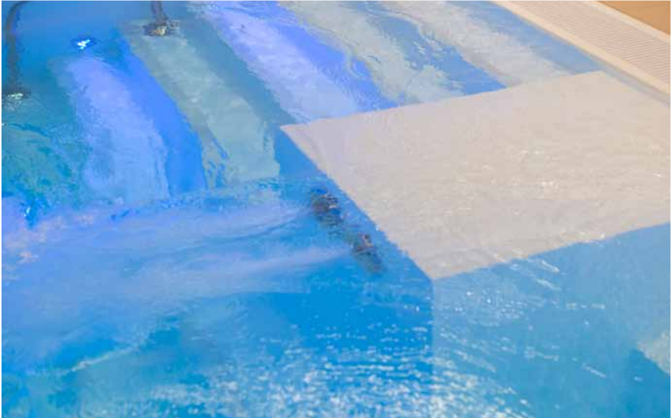
Ein Startblock, in dem die Gegenstromanlage integriert ist, unterteilt die Treppe in einen Treppenbereich und eine Sitzbank mit integrierten Sprudeldüsen.
