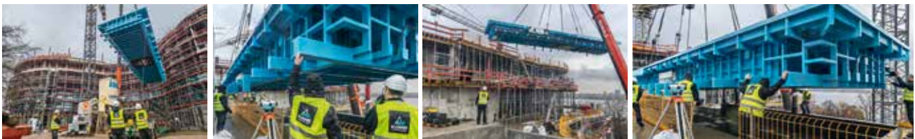
Bilder oben: Die tolle Aussicht von der Wellnessterrasse des Hotels auf Hamburg. Die Bildfolge unten zeigt die Einbringung des 20 Tonnen schweren Beckens.
