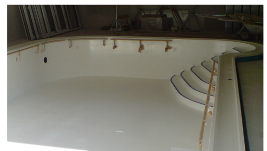
Oben: Whirlrotunde mit zahlreichen Luftsprudeldüsen. Darunter: In zwei Teilen wurde das VPS-Becken eingebracht und dann zusammengebaut.
