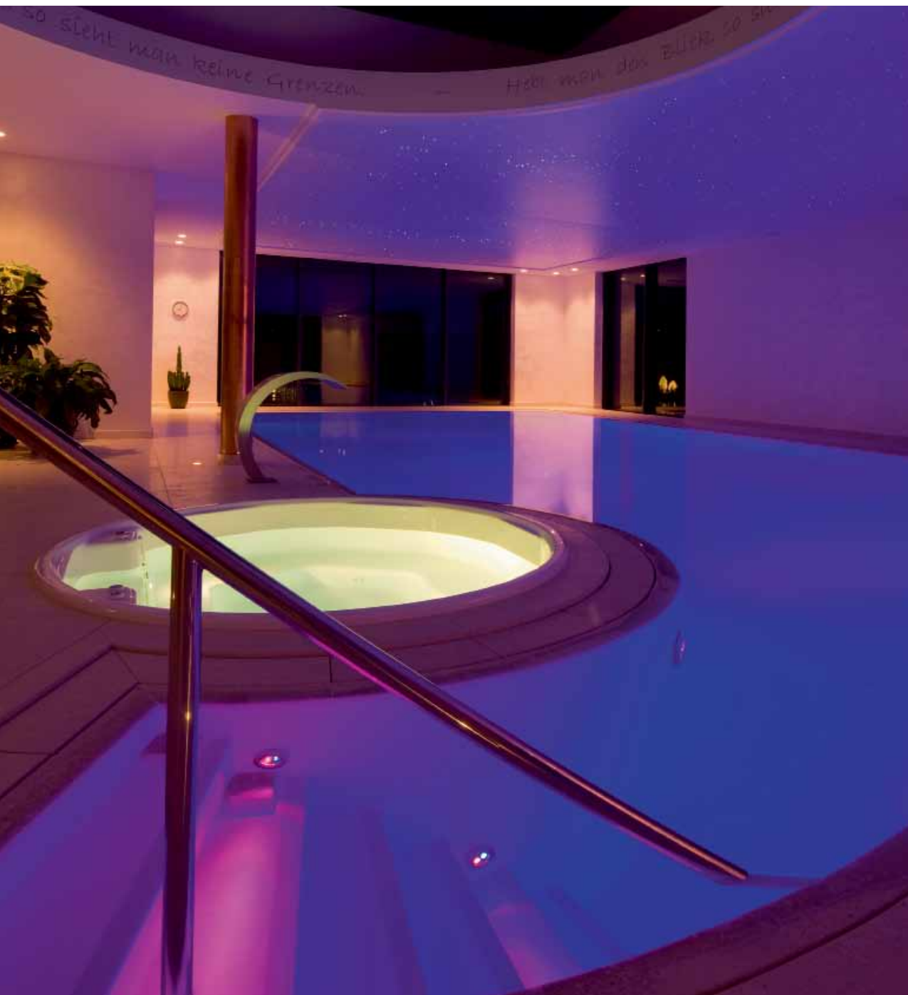
Sechs LED-Unterwasser-scheinwerfer mit Farbwechsel erzeugen unterhaltsame Lichteffekte im Pool.
