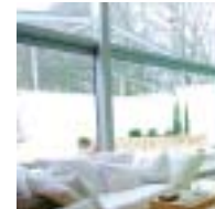
KNOW-HOW Die warme Luft wird über Schlitz- schienen an den Fenstern abge- schleiert.
