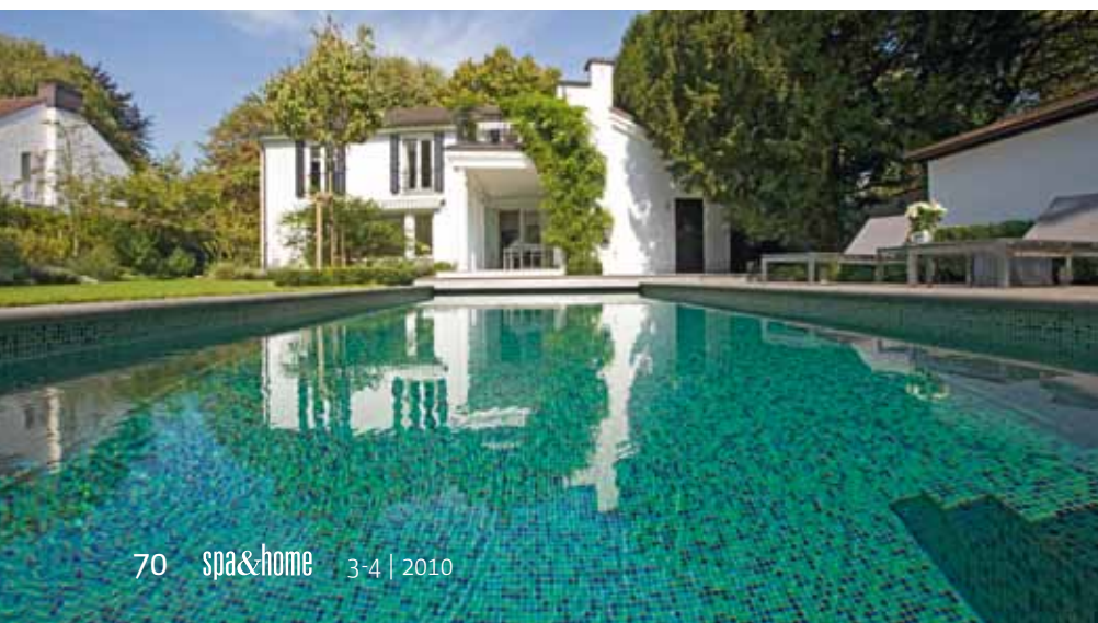
VPS-Schwimmbecken aus dem „S-Line“-Programm mit Mosaiken ausgekleidet.
