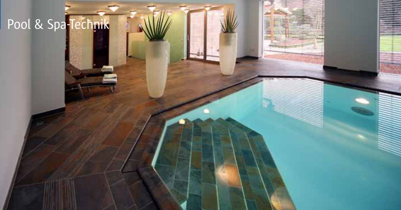
Einstiegstreppe eines VPS-Becken mit Naturstein abgesetzt und mit Natursteinrinne.
