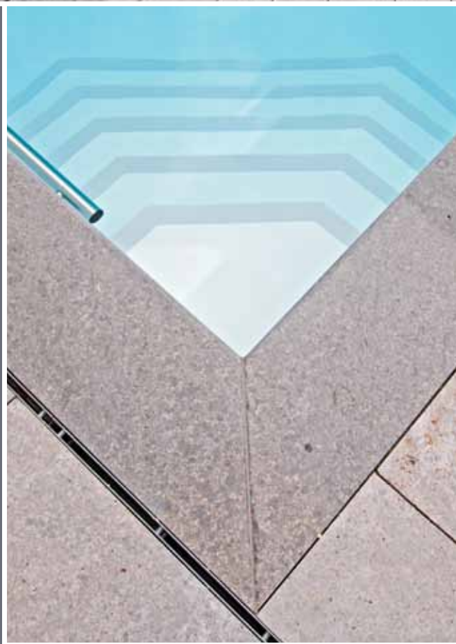
Dank grau abgesetzter Stufenkanten ist die Treppe gut zu erkennen und der sichere Gang ins Wasser garantiert.
